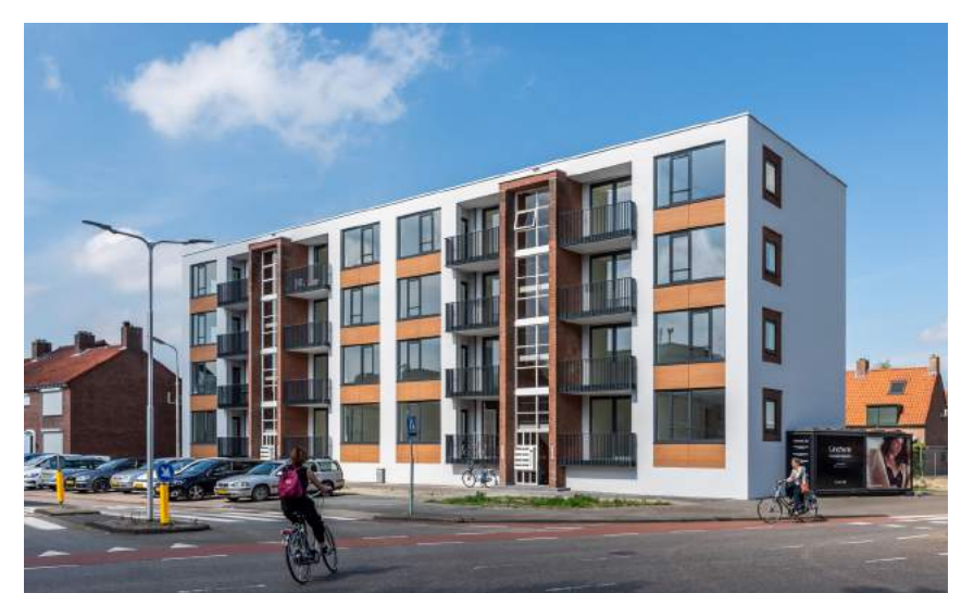
BLOK D - RENOVATIE GEREALISEERD
